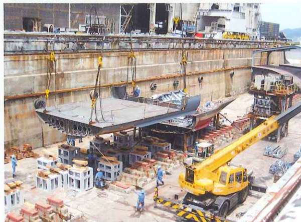
船台搭載開始 / Start of block erection
