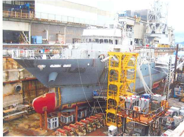
上部構造搭載 / Election of superstructure
