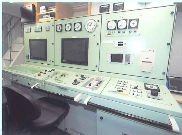
機関制御室 / Engine control room
